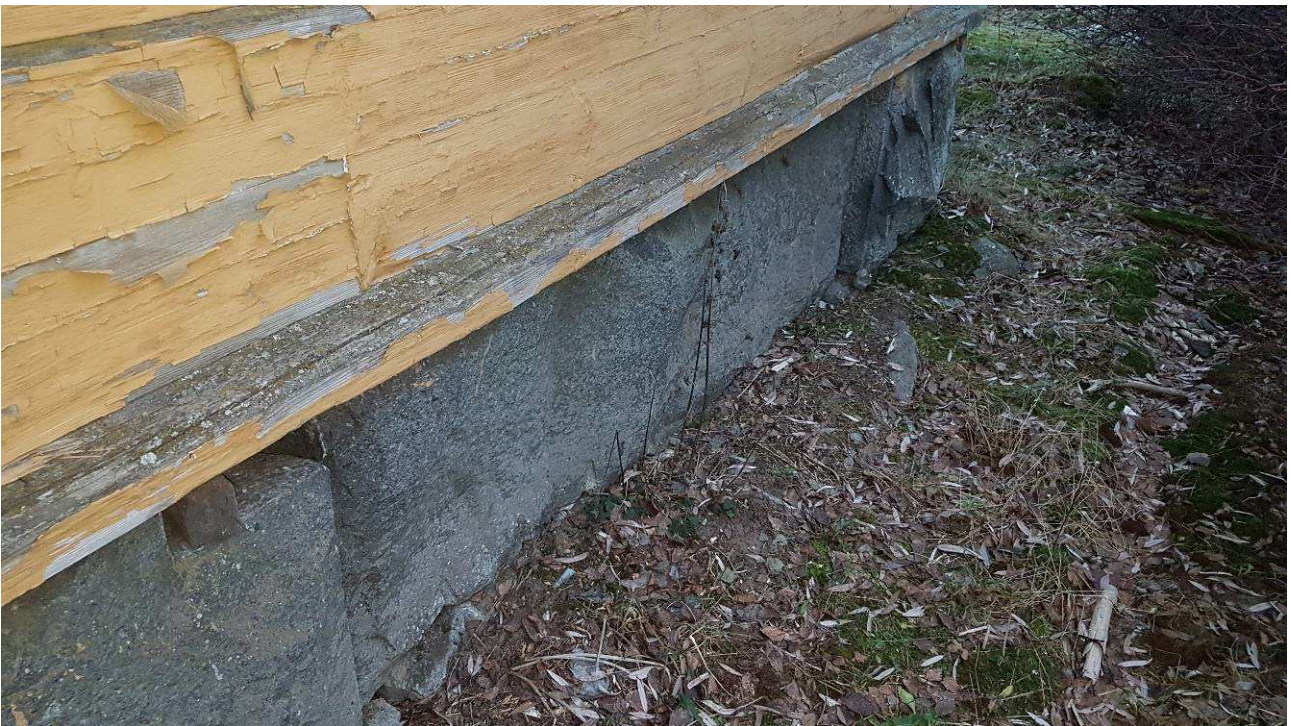
Muutamassa porakivessä pientä sivuttaisliikettä
