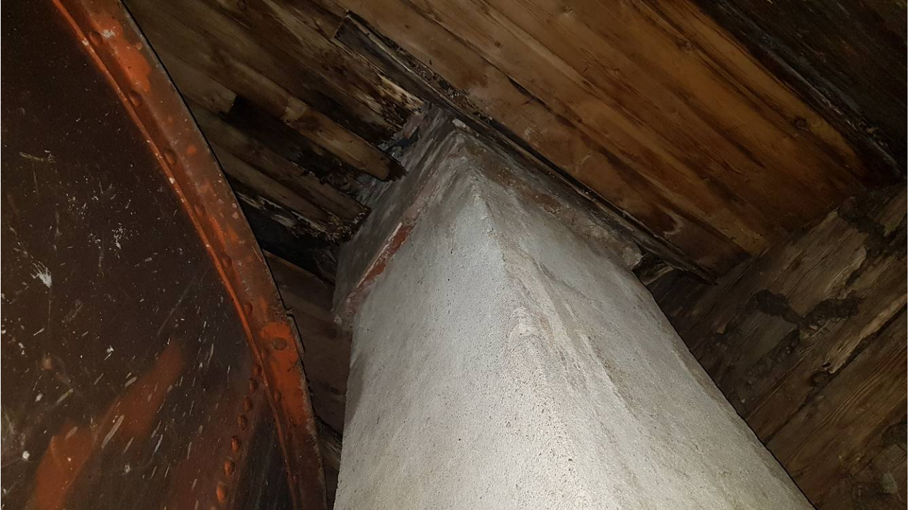
Sisältä savupiipun juuren vuotojäljet
