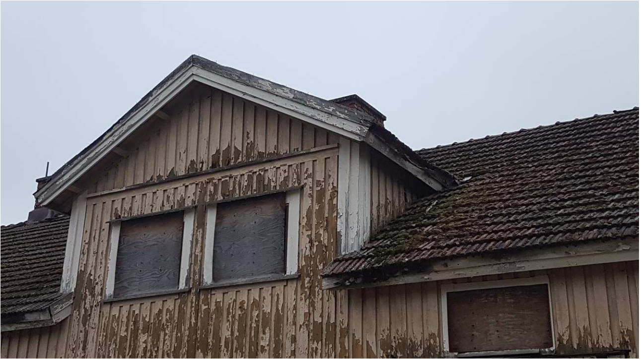
Ei rintapelti seinällä, otsalaudat lahonneet.
