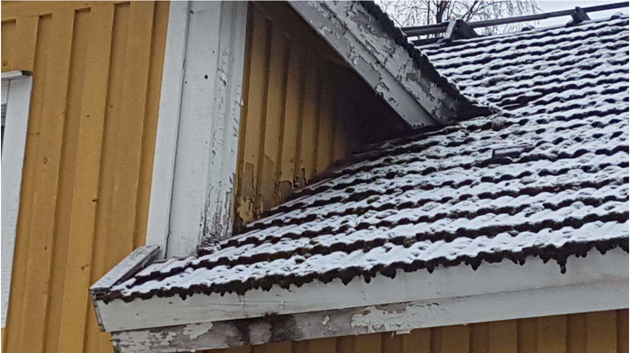
Rintapellit puuttuu
