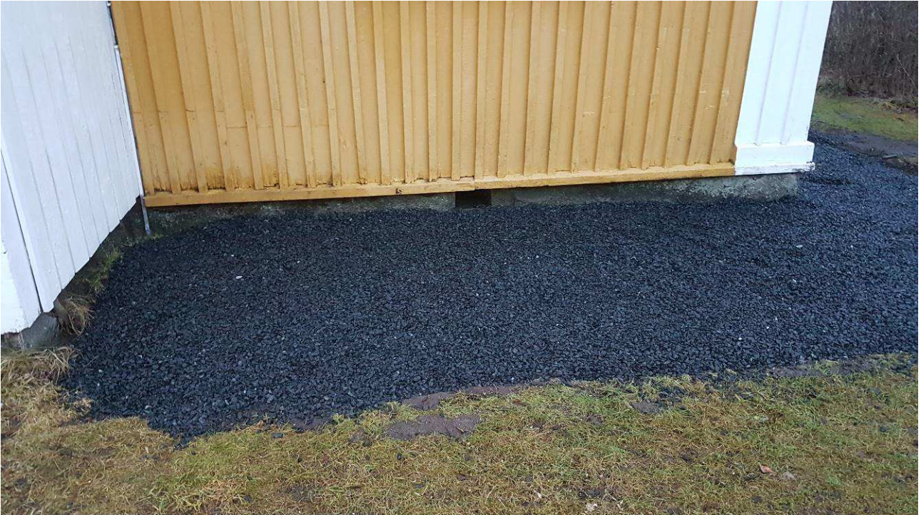
Maanpinta on korkealla. Kivijalan vieressä on vettä läpäisevää sepeliä
