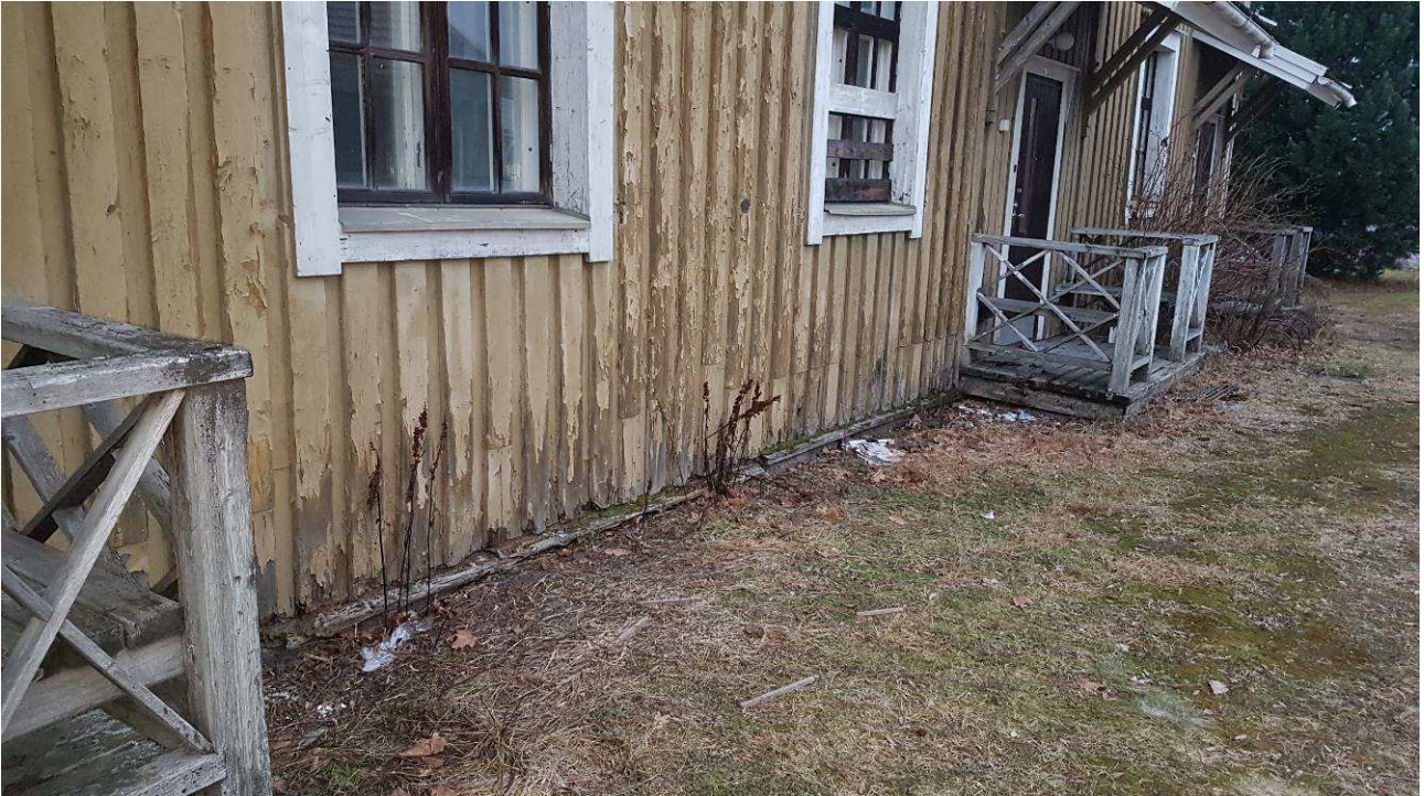
Etusivulla manapinta on korkealla. Ulkoseinän alaosassa lahovaurioita Oven edus tasanteet ovat huonossa kunnossa
