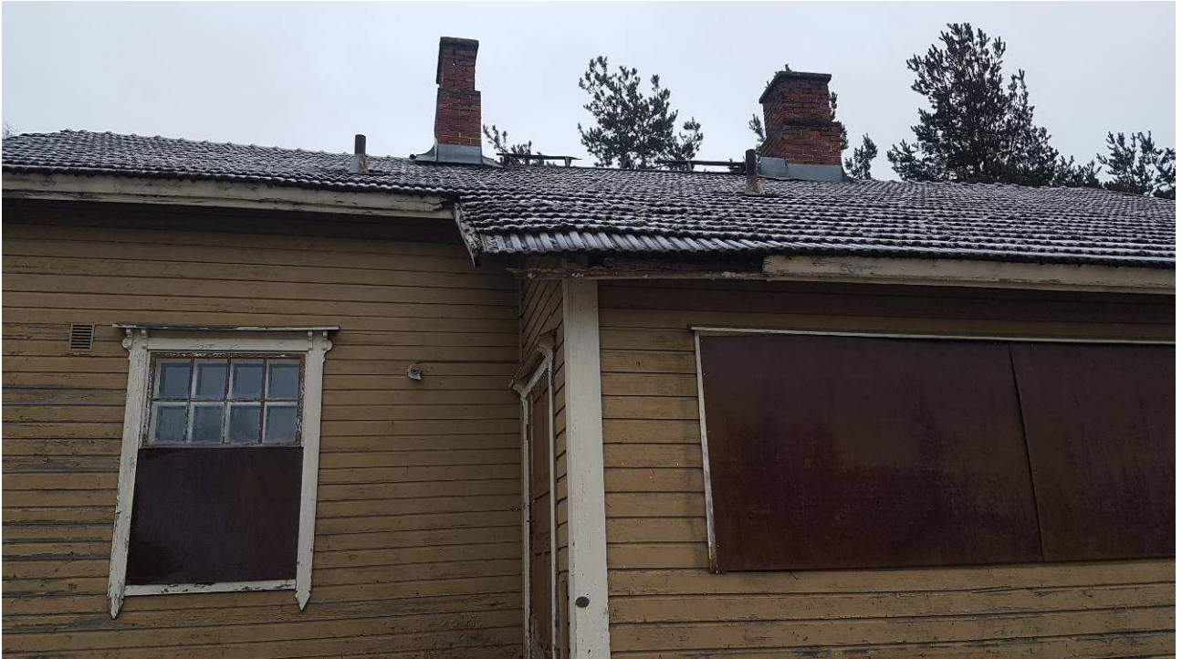
Tiilikate on huonokuntoinen, savupiipun yläosat ovat huonossa kunnossa
