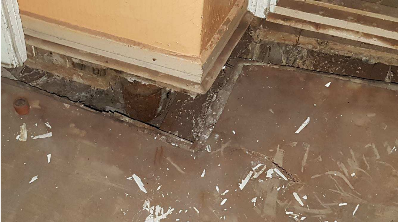
Alapohja rakenne pettänyt, lattiat painuneet
