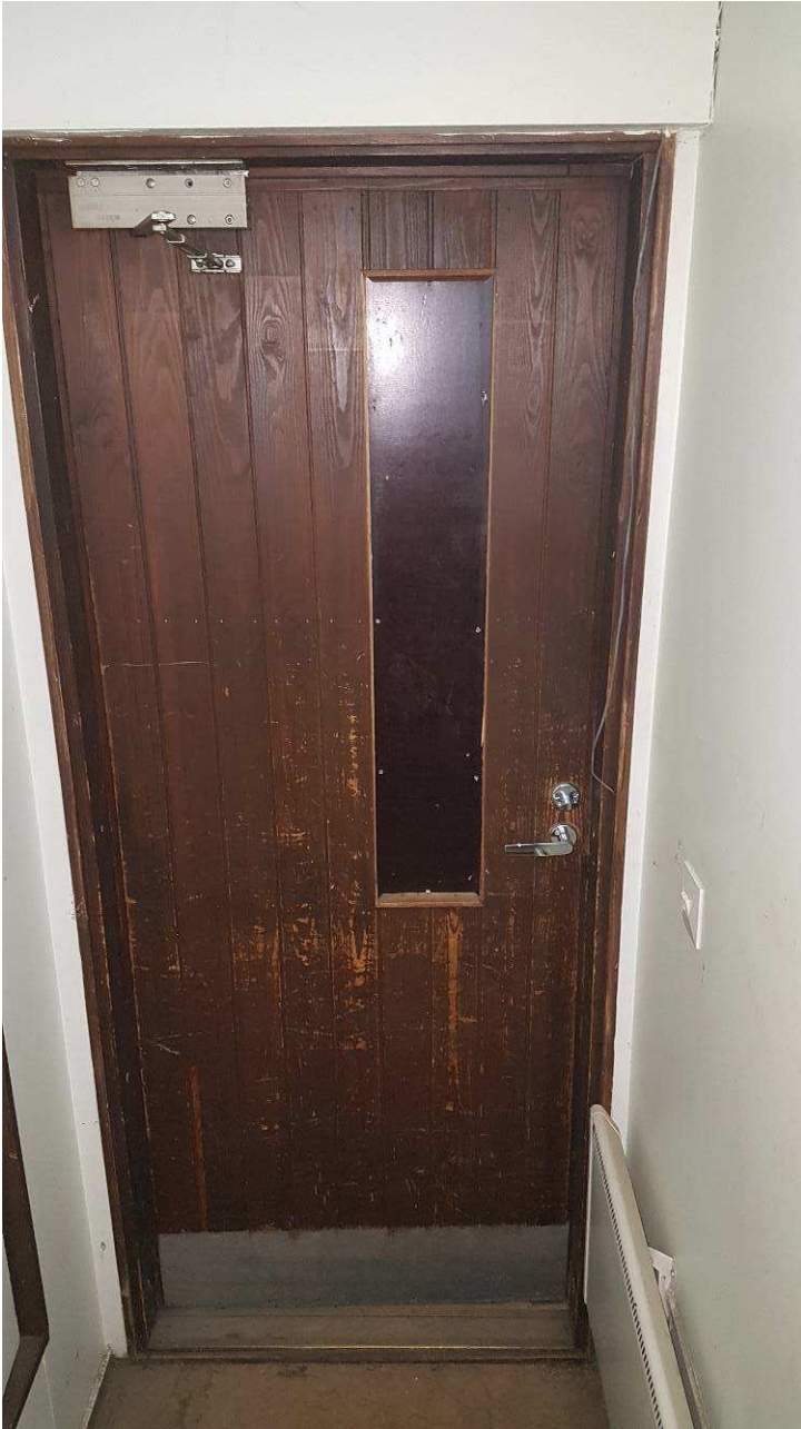
Ulko-ovista on lasoja rikki ja muutoinkin ovet kuluneita
