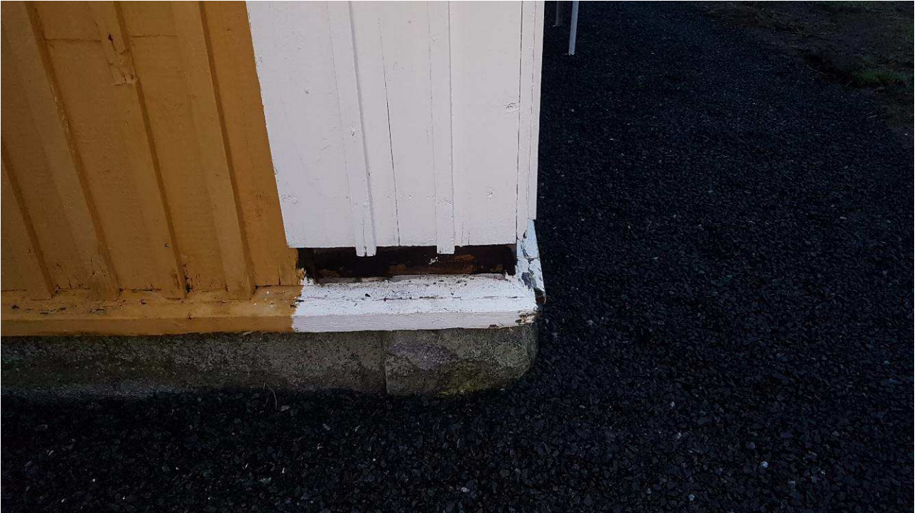
Nurkasta puuttuu alalauta
