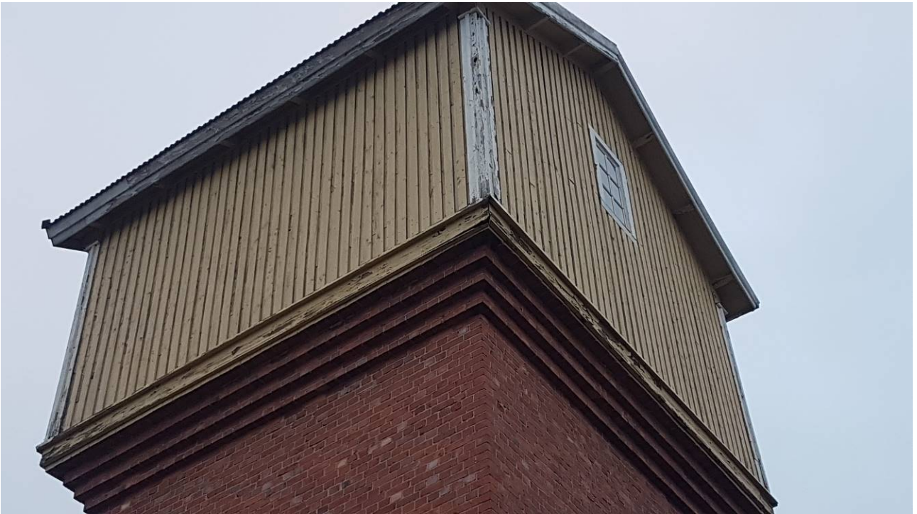
Yläosan puuosien maali hilseillyt ja vuorauksessa lahovaurioita.
