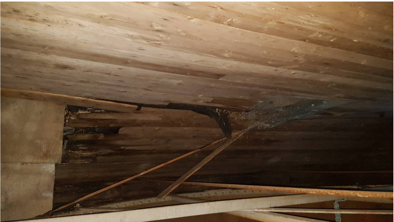
Sisältä savupiipun juuren vuotojäljet
