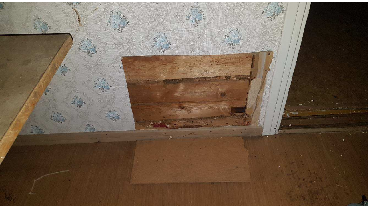
Hirsiseinää tarkistettu ok
