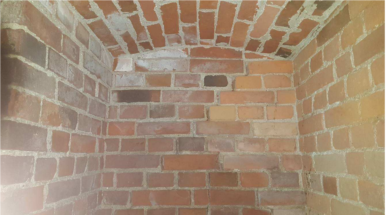
Sisäseinissä on halkeamia, katto tiili holvia
