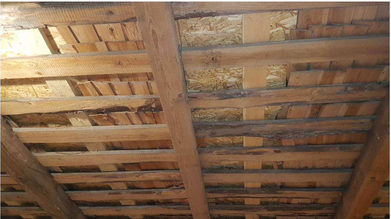
Uuden vesikaton alle on laitettu osb-vaneri
