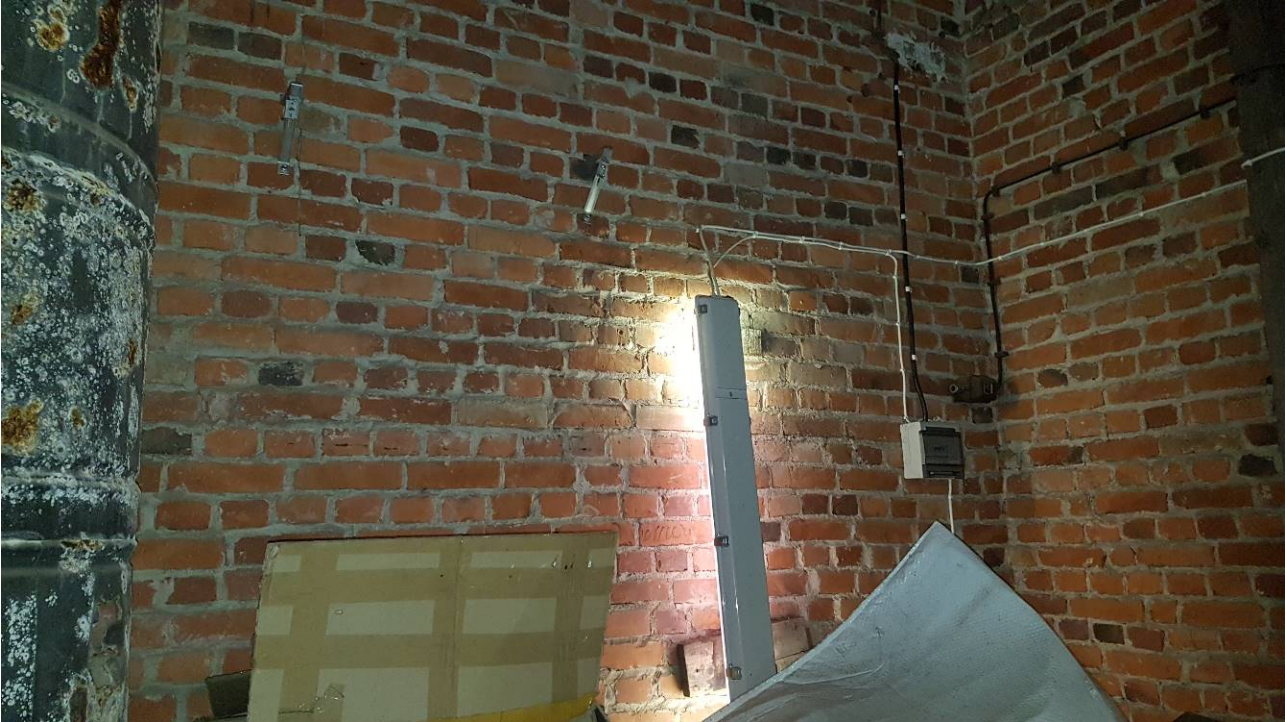
Alaosan valaistus ja niiden sähköt uusittu (valaisin irti) muutoin sähköt ovat vanhoja ja ei käytössä.
