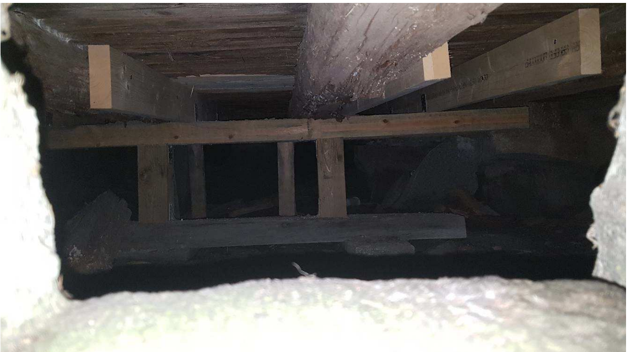
Alapohjaa on lisätuettu
