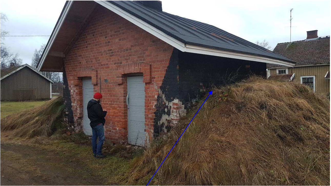
Maanpinta viettää päältä rakennukseen päin
