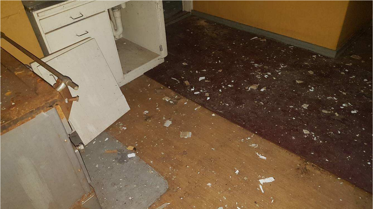
Ja keittiöstä lattiaa korjattu levyllä.
