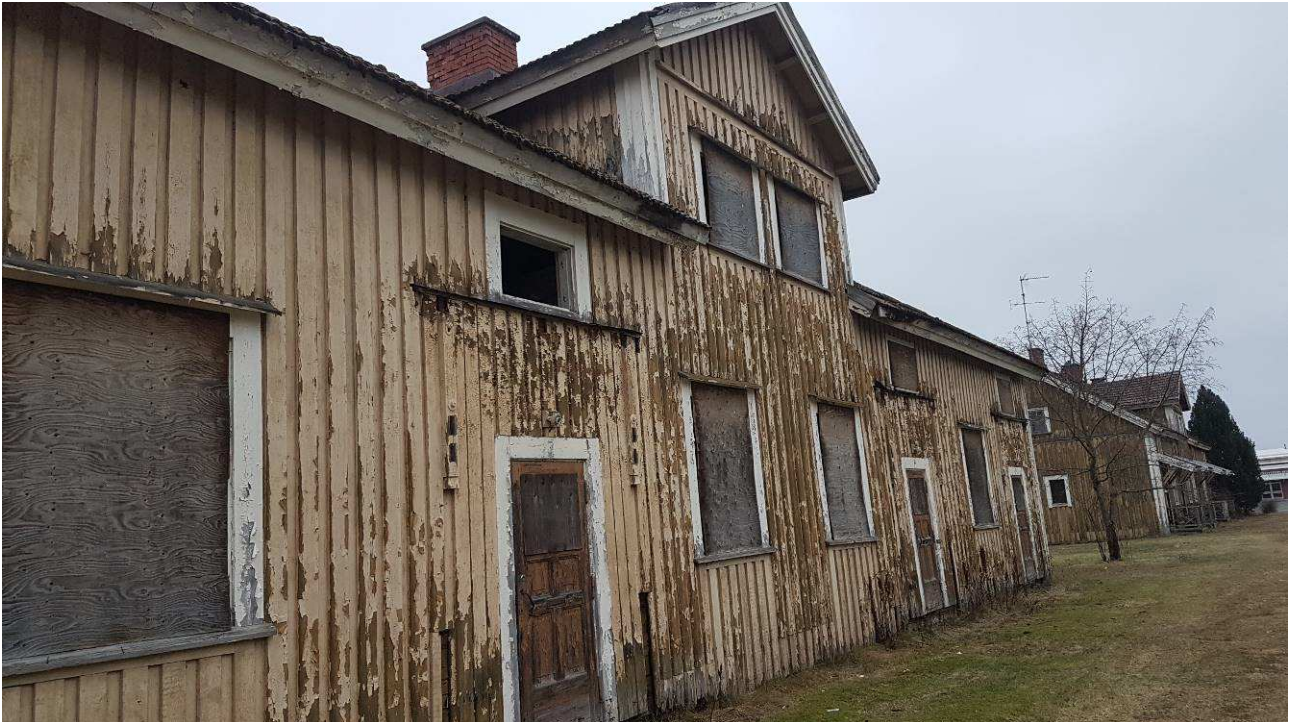
Etusivulla maanpinta on korkealla, ovien päältä katokset purettuna ja porrastasanteet ovat purettuna
