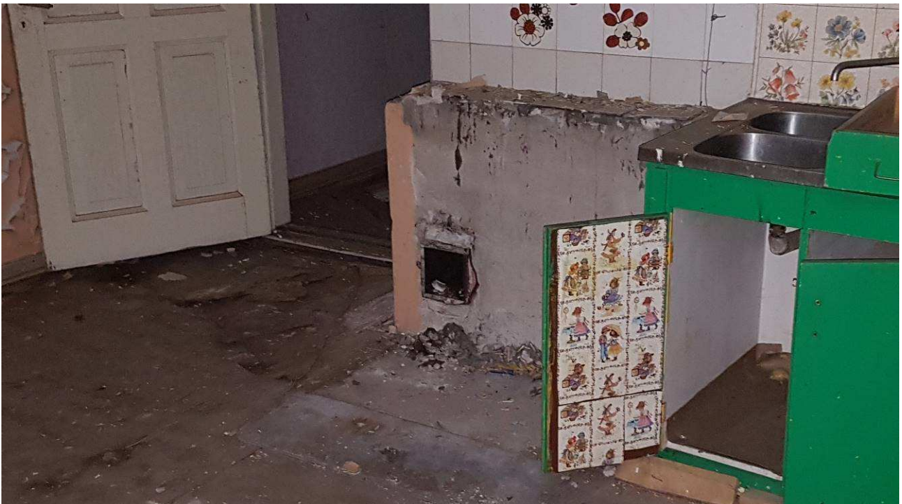
Alapohja rakenne pettänyt, lattiat painuneet
