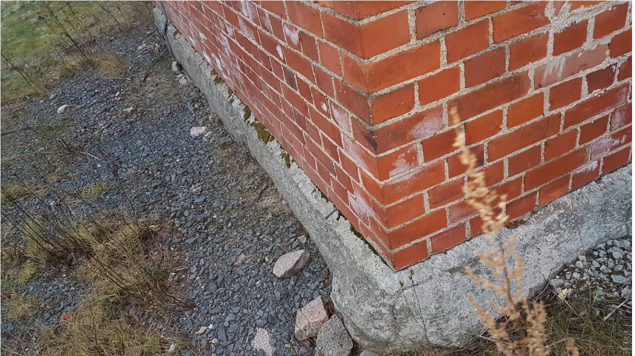
Perustukset ovat pysyneet hyvin paikoillaan
