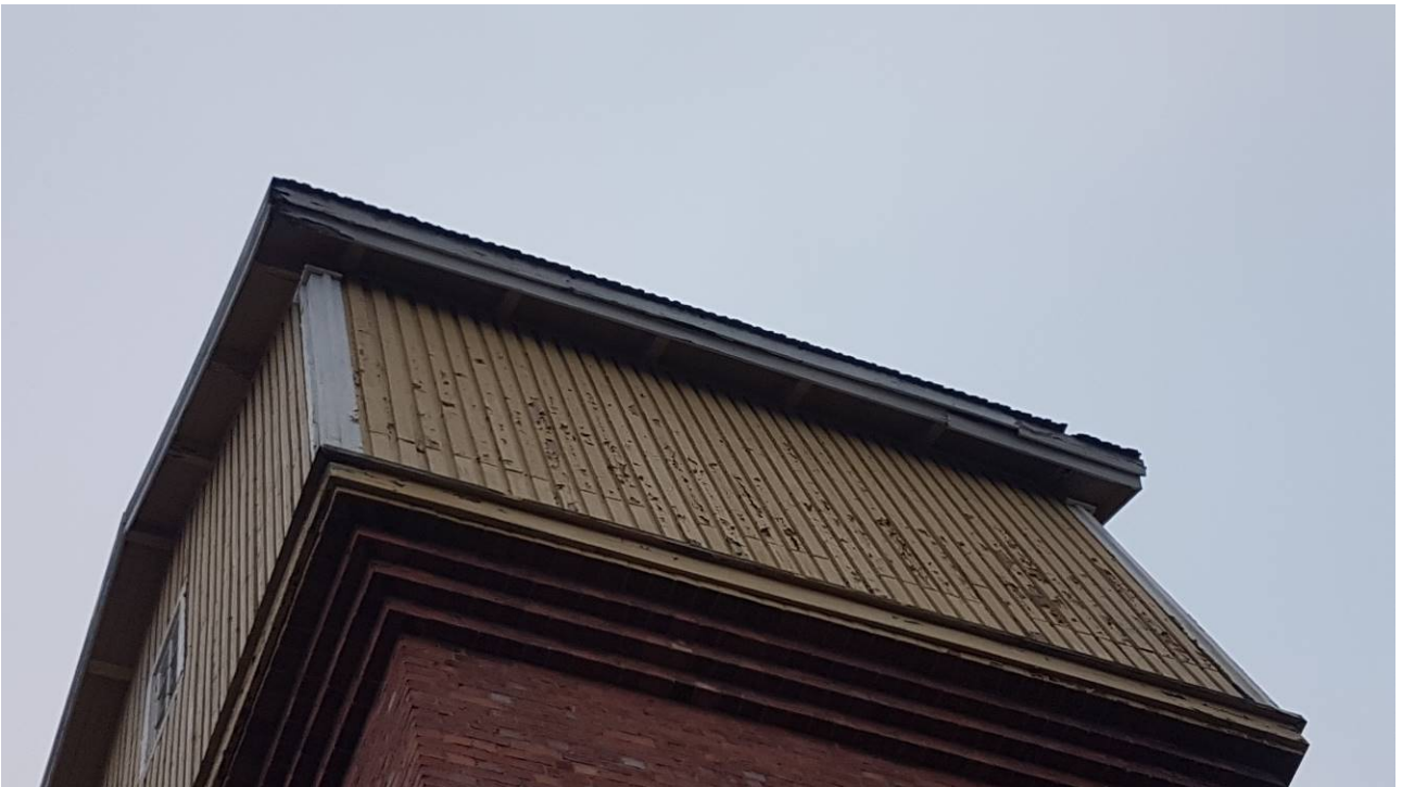
Yläosan puuosien maali hilseillyt ja vuorauksessa lahovaurioita.
