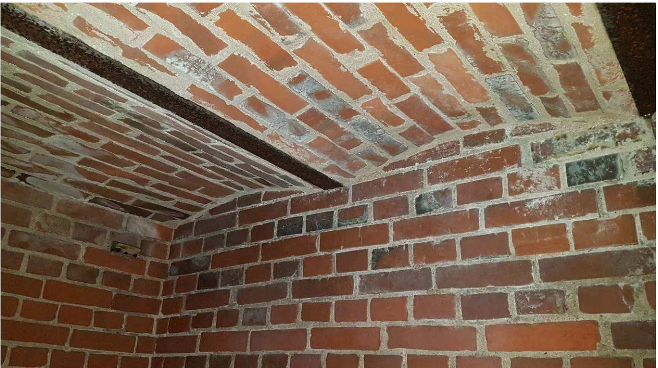
Sisäseinissä on halkeamia, katto tiili holvia
