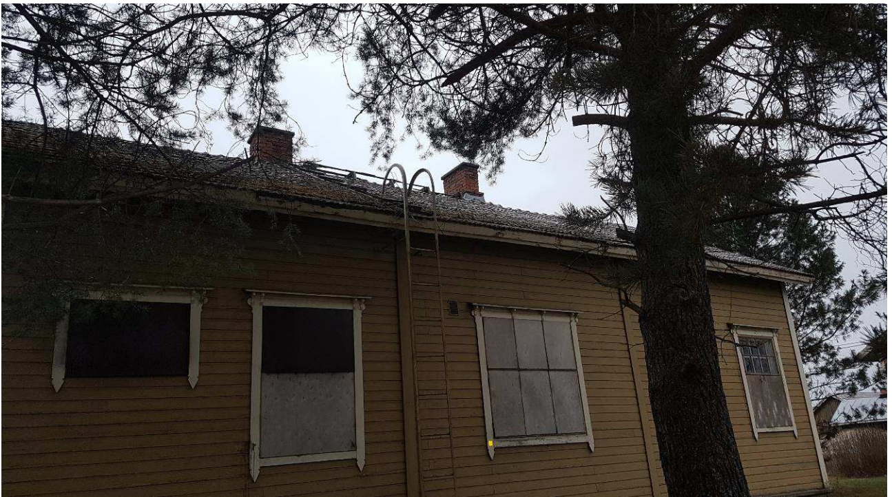
Tiilikate on huonokuntoinen, savupiipun yläosat ovat huonossa kunnossa
