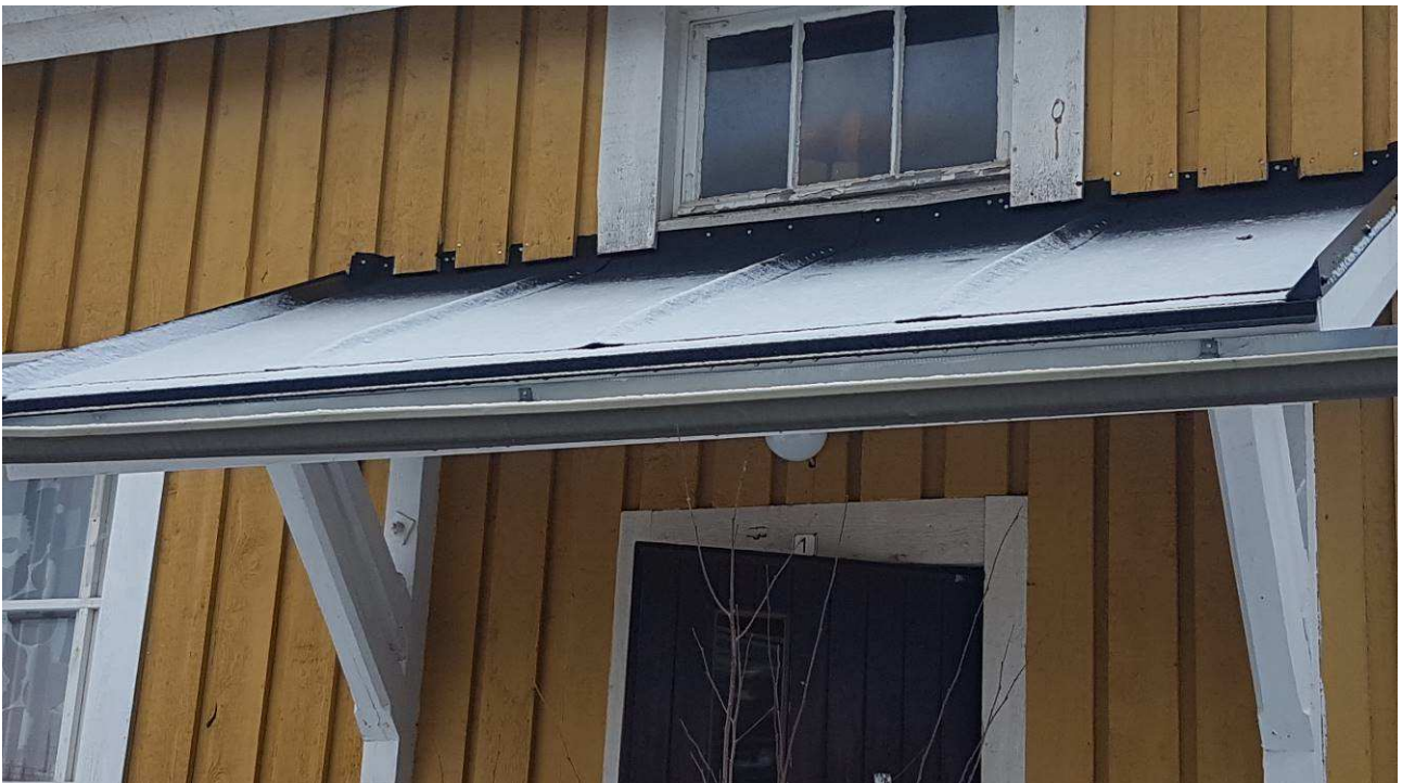
Ovilippojen päälle uusittu kate
