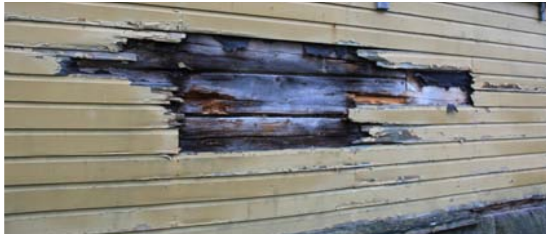
H: Huomattava paikallinen vaurio. Lautoja on irronnut ja hirsirunko on tullut näkyville. Epäillään että joku työkone olisi vaurion takana. Hirsirakenne on jo pahoin vaurioitunut ja joistain kohdista pinnastaan laho. Vauriokohta pitäisi suojata pikimmiten. Hirret on korjattava ennen julkisivun paikoitusta. Vaurion korjaus tai ainakin suojaus on kiireellinen, ettei vaurio pahene tai leviä entisestään. Jos vaurio paikataan väliaikaisesti, paikkaus ei saa olla liian tiivis ja hengittämätön. Paikkauksen täytyy päästää vesihöyry läpi, mutta pitää sadevesi ulkona.
