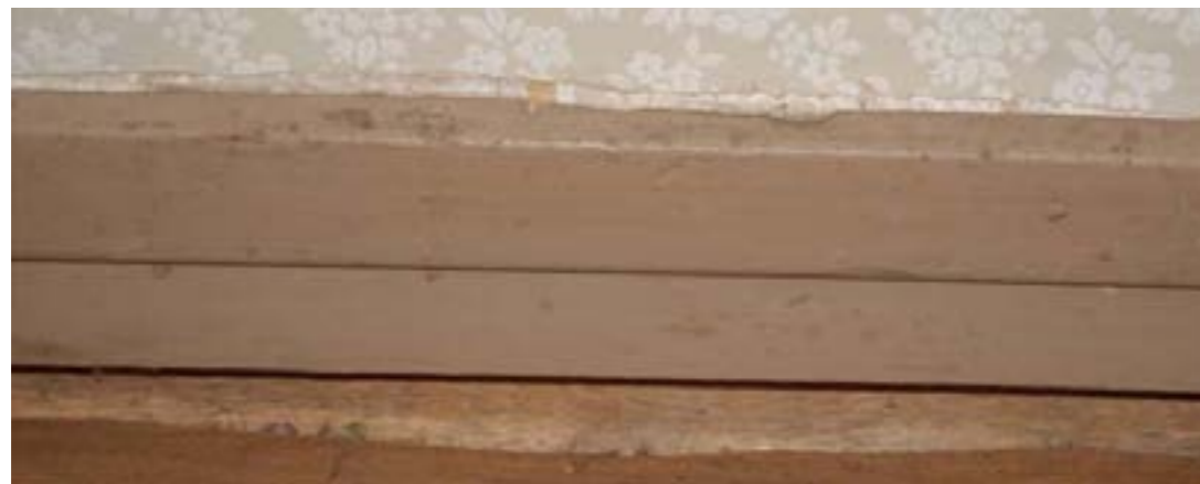
Lattialistatyyppi L2 (päällimmäinen rima poistettu)
