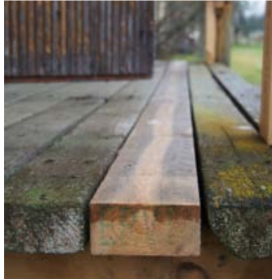
Liite 2: Portaiden lankut ovat huonossa kunnossa ja kasvavat sammalta. Yksi lankku on vaihdettu.
