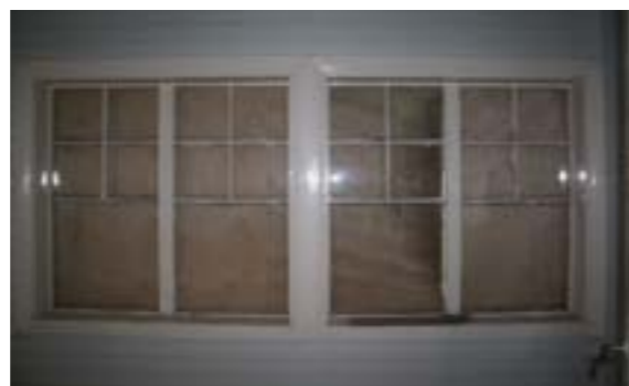
Kuistin ikkunat F03 ja F04
