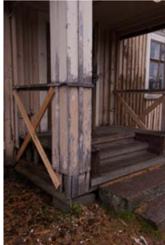
Kuistin ilme tulisi palauttaa Asemapäällikön taloon sopivaksi. Vähäinen kuistin painuminen voidaan jättää korjaamatta, se kertoo rakennuksen iästä ja historiallisesta arvosta.
