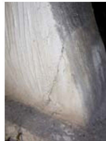
Kuva 6. Pohjoisen puoleinen hormi
