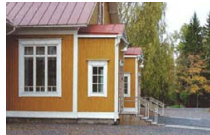
Valkoinen peltikouru ja syöksytorvet suppiloineen sulautuvat valkoisiin nurkkalautoihin (lähde: Laine, Orrenmaa: Rakkaat vanhat puutalot)
