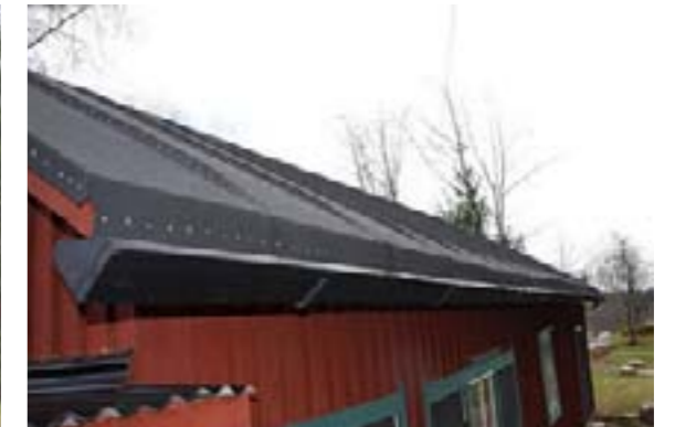
Esimerkki puisesta räystäästä huopakatteen yhteydessä (lähde:www.suomela.fi)
