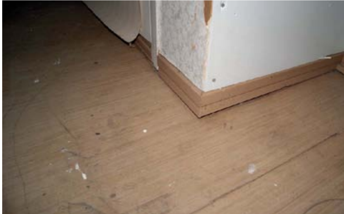
Kuva E9 Lattia painunut herran huoneessa jättäen raon listan ja lattian väliin (H103)
