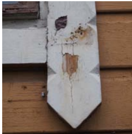
Liite 3: Ruostunut naula, ruoste puskee maalipinnan läpi.
