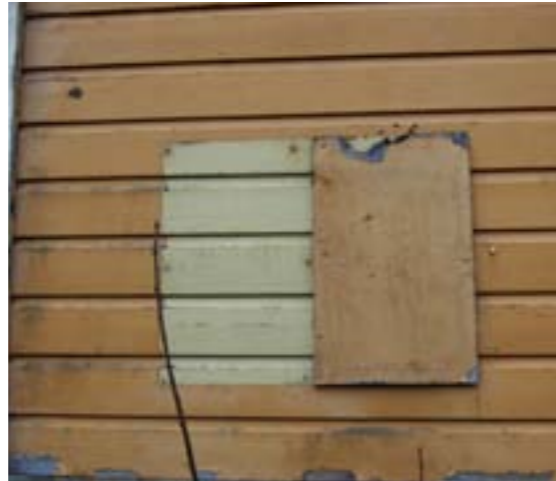
Liite 5: Vanha ilmoitustaulu on osittain poistettu ja sen alta on paljastunut 50-luvun maalikerros.
