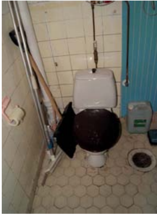
Kuva E35 Vessan lattia- ja seinämateriaalit ovat 50-luvulta, pinnat likaisia ja huonokuntoisia (H110)
