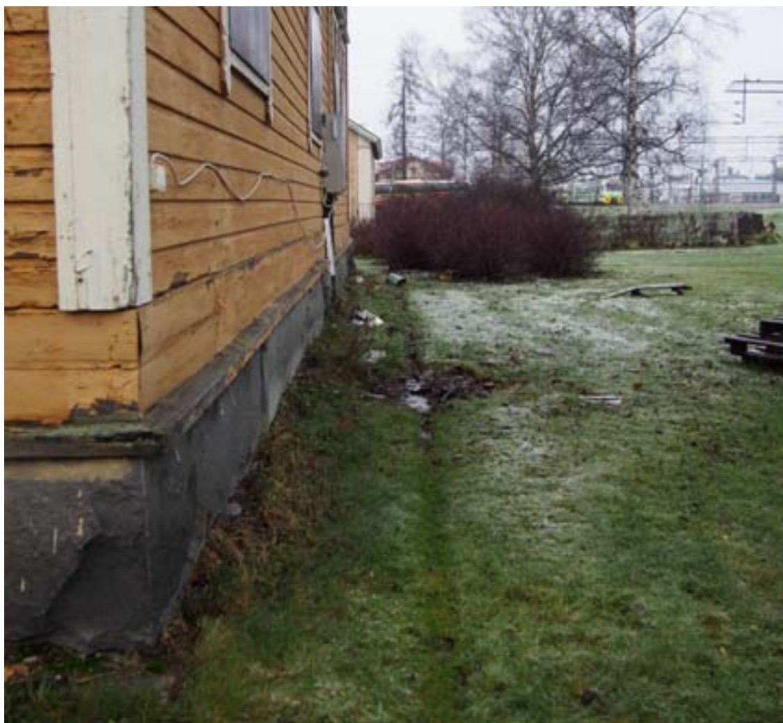
Liite 4: Räystäältä tippuva vesi on muokannut uran maahan.
