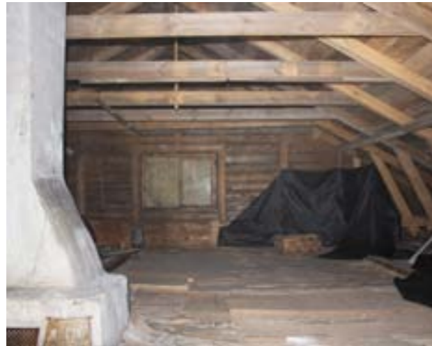
Kuva 1. Yleisnäkymä ullakolta pohjoiseen päin.
