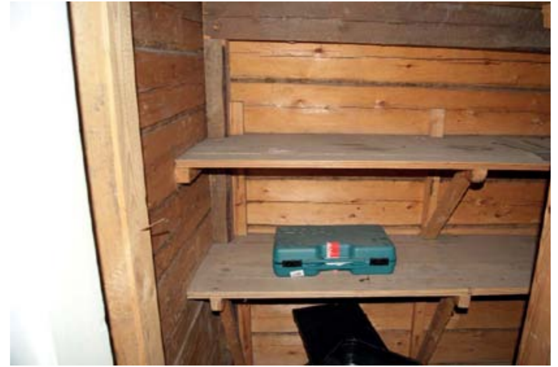
Kuva E32 Portaiden alla sijoitseva komero hyvässä kunnossa (H109)
