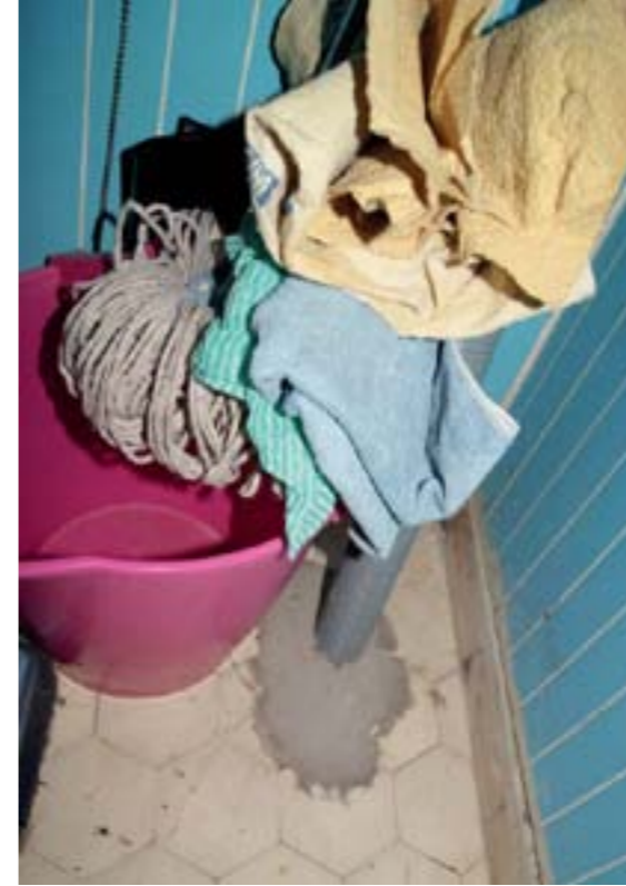
Kuva E38 Vessan nurkassa olattian läpäisevä putkiveto
