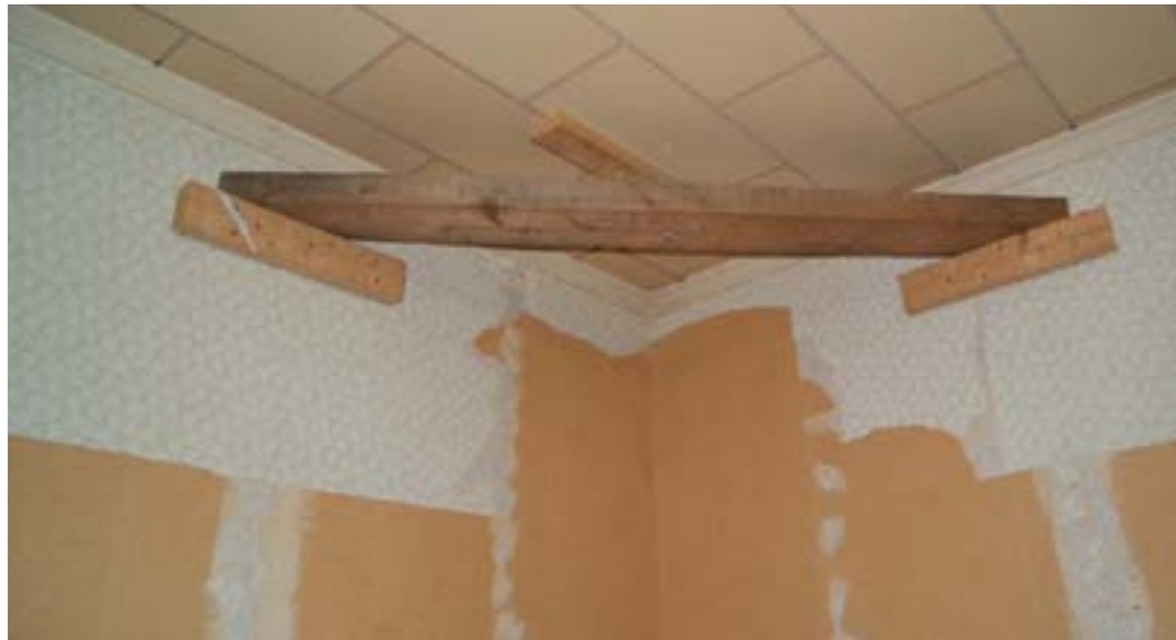
Kuva E1 Ripustukseen tarkoitettu palkkiratkaisu salin nurkassa. (H104)
