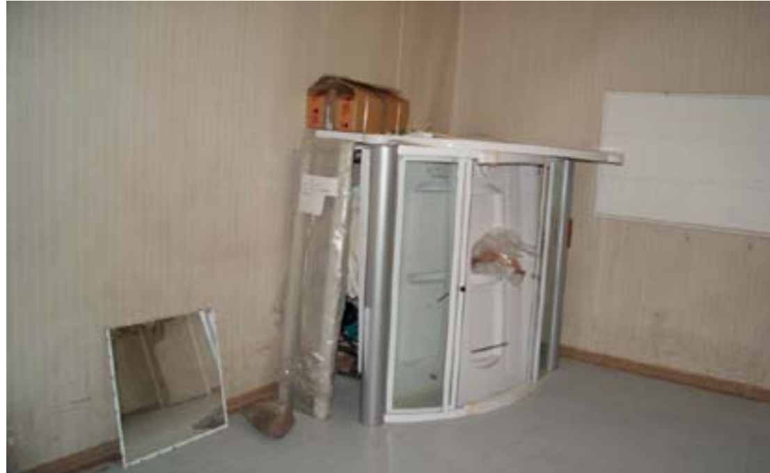
Kuva E7 Ruokasalin nurkassa asentamaton suihkukaappi sekä muuta rojua, lisäksi tapetit likaiset (H105)
