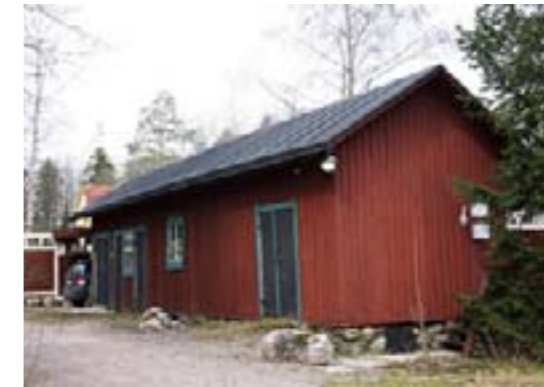
Esimerkki puisesta räystäästä huopakatteen yhteydessä (lähde:www.suomela.fi)
