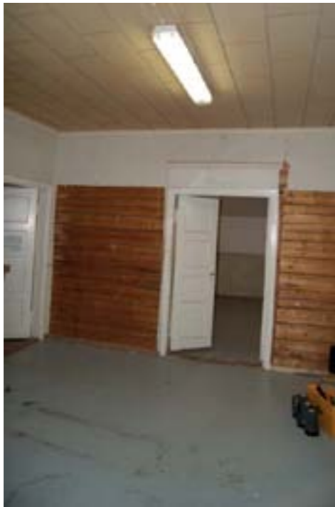
Kuva E2 Salin alkuperäinen hirsiseinärakenne näkyvässä (H104)
