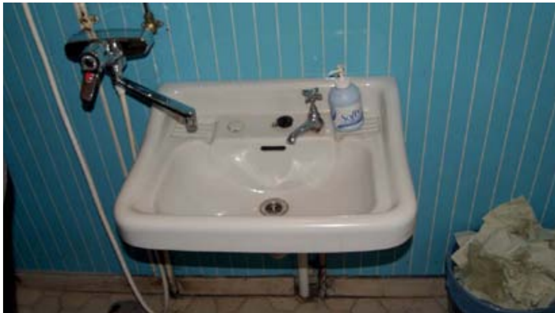
Kuva E37 Vessan lavaari 50-luvulta. Oikeanpuoleinen hana 2000-luvulta, vanha hana jätetty kuitenkin paikalleen (H110)
