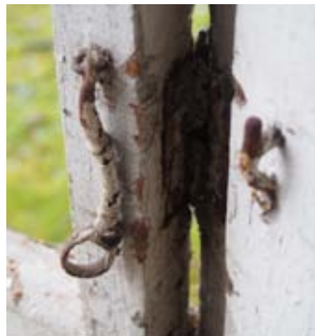
Liite 5: Heloitus ruostunut, sisäpuolen maalipinta lohkeillut ja kulunut.
