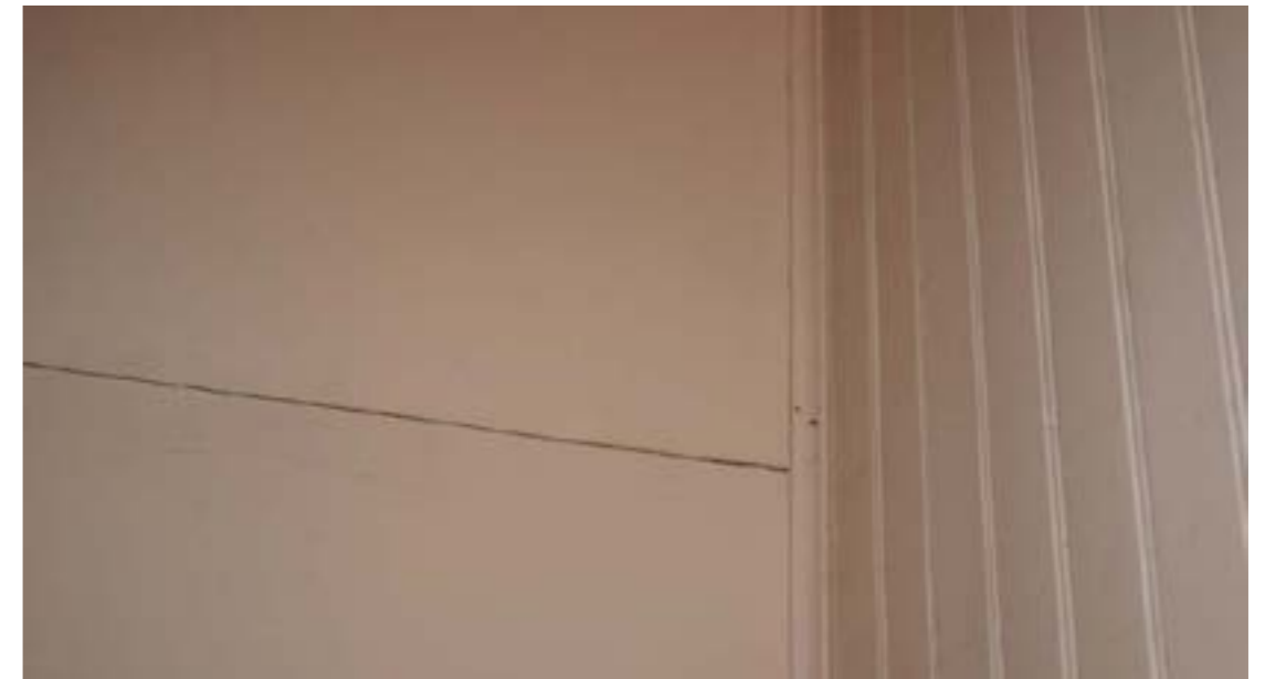
Kuva E34 Paneleiden vaakasaumat eläneet. Alkuperäistä pystypanelointia (H109)
