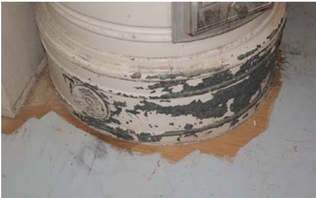
Kuva E8 Viimeistelemätön maalaus ruokasalin lattiapinnan päällä, kulumaa tulisijan maalipinnassa, kipinäpelti uupuu. (H105)
