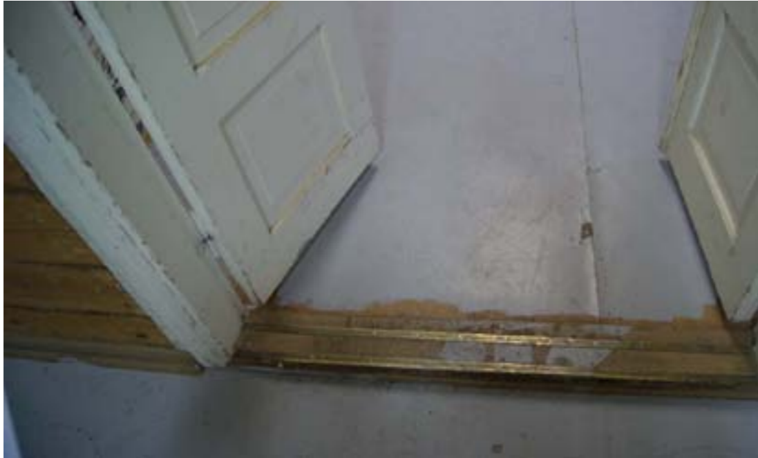
Kuva E4 Salin ja ruokasalin välinen kynnyksen huonokuntoinen (H104, H105)
