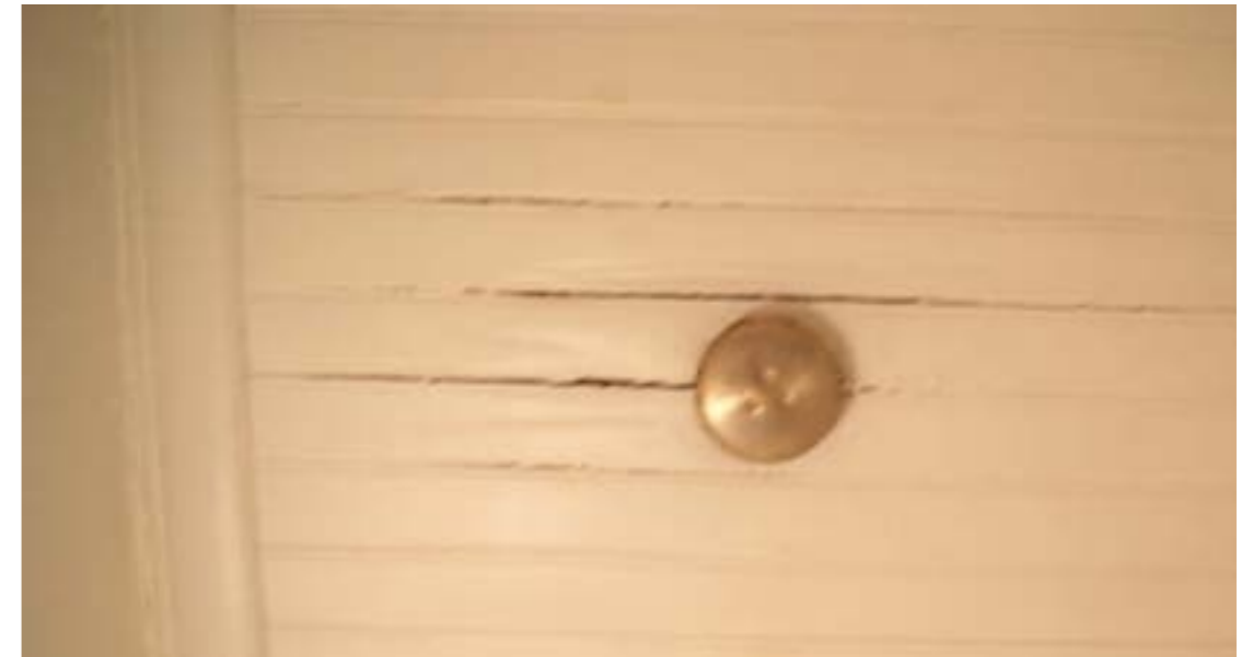
Kuva E40 Vessan katossa alkuperäistä kattopaneelia, sekä mahdollisesti alkuperäistä kattolistaa (H110)
