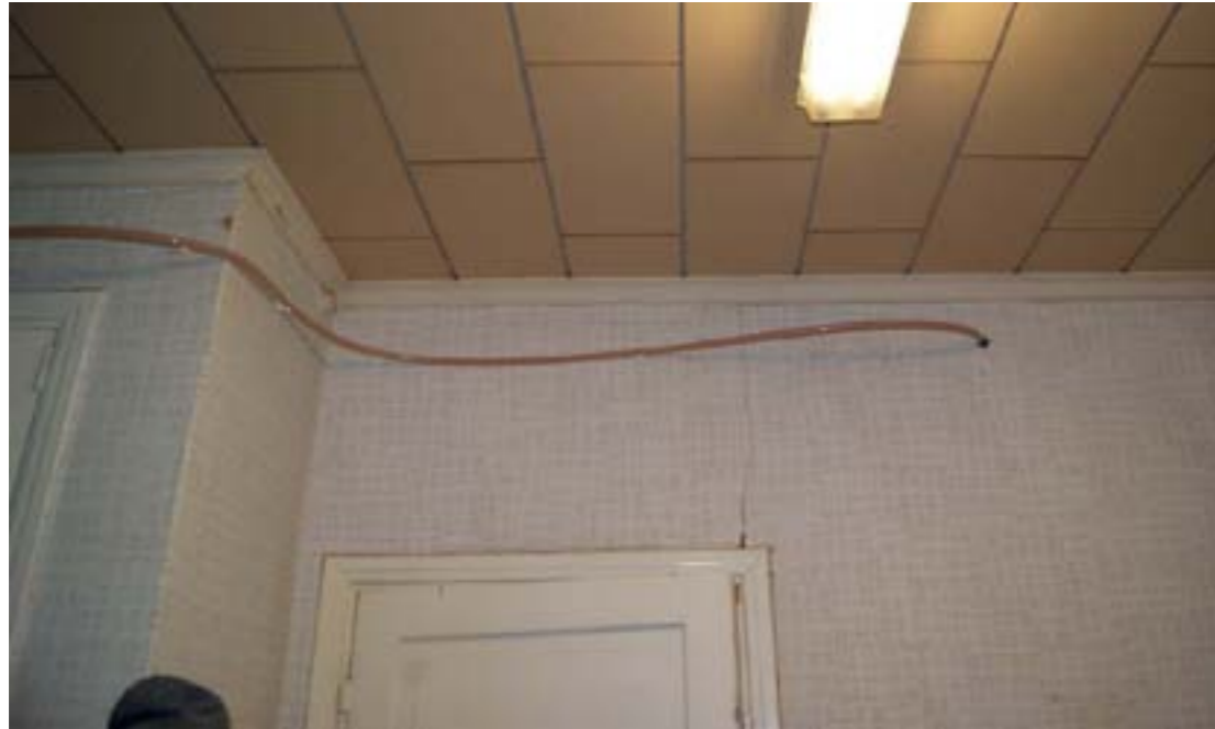
Kuva E17 Näkymä makuuhuoneen ja keittiön välisen oven yläpuolelta. Tökerö vesijohdot veto, sekä halkeama seinässä. (H106)
