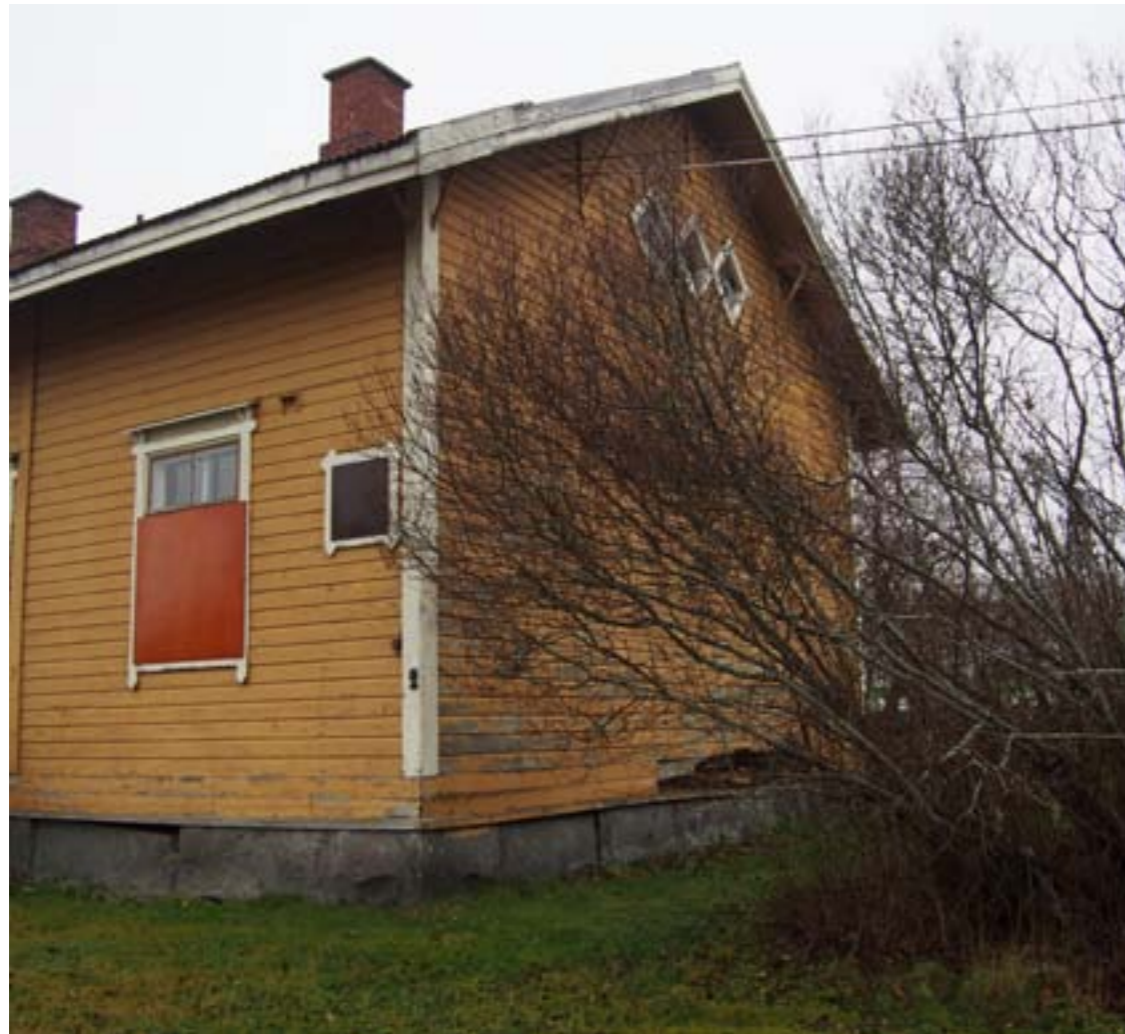
Liite 2: Pensaankokot ulottuvat julkisivuun.
