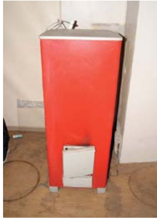
Kuva E28 Kamina siirretty paikaltaan (H108)
