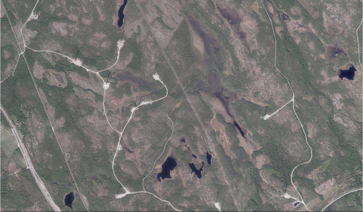
Kuva 14. Ilmakuvassa näkyvä tuulivoimapuisto huoltoteineen ja voimala-alueineen (lähde: Maanmittauslaitos, ilmakuva)
