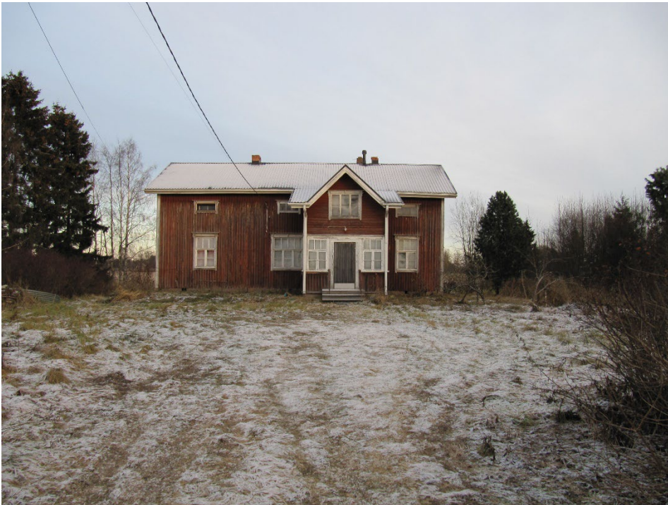
Kuva 18. Kiinteistö 977-406-0012-0102: asuinrakennus (asumaton), v. 1920.
