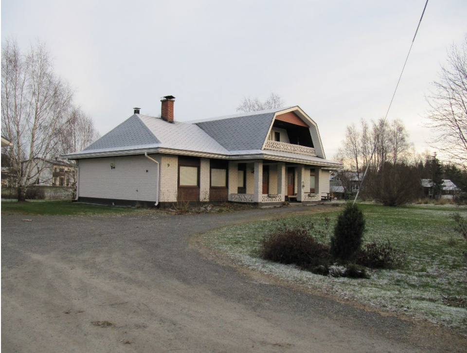
Kuva 21. Kiinteistö 977-406-0012-0067: päiväkotikäytössä, v. 1983.
