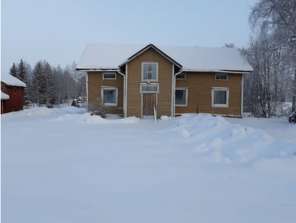
Kuva 19. Kiinteistö 977-406-0012-0039: asuinrakennus (asumaton), v. 1915.
