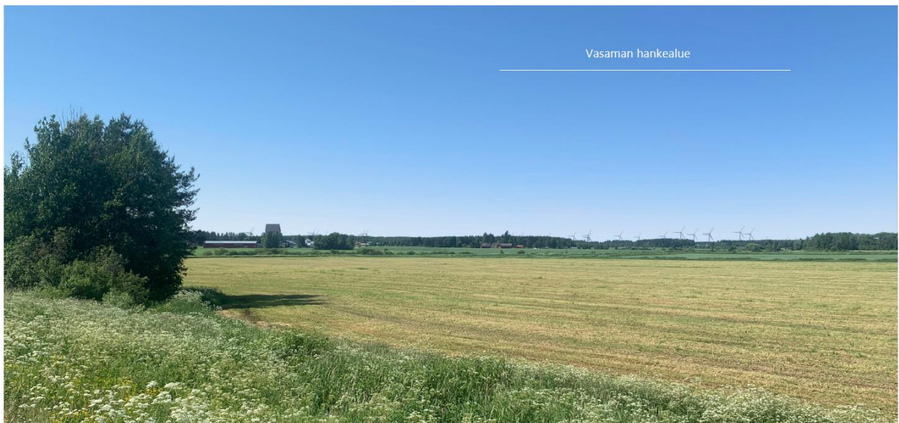
Kuva 169. Kajaanintieltä Malikylän länsipuolelta tehty kuvasovite.
