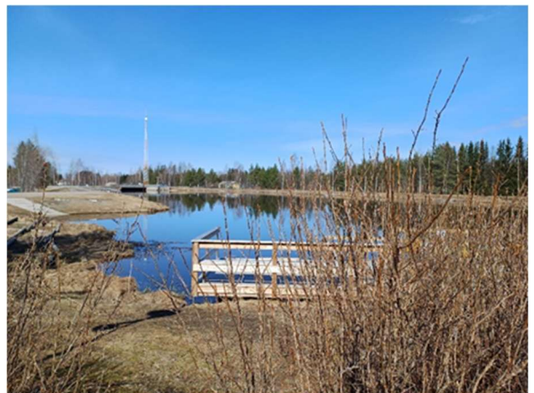
Kuva 7. Hamarin voimalapato sijaitsee rannan välittömässä läheisyydessä
