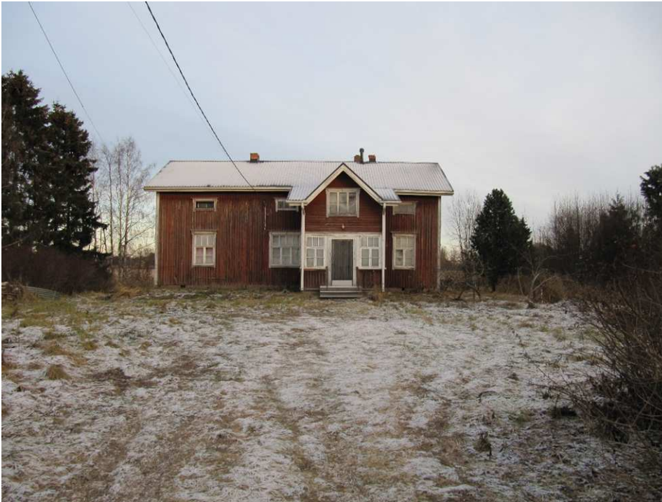
Kuva 18. Kiinteistö 977-406-0012-0102: asuinrakennus (asumaton), v. 1920.
