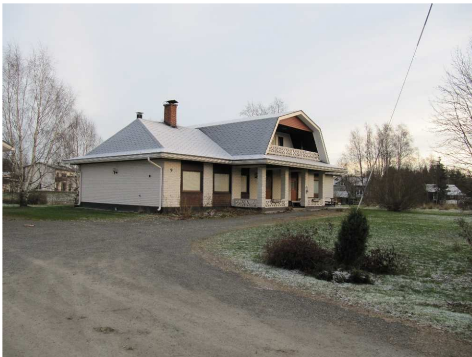
Kuva 20. Kiinteistö 977-406-0012-0067: päiväkotikäytössä, v. 1983.
