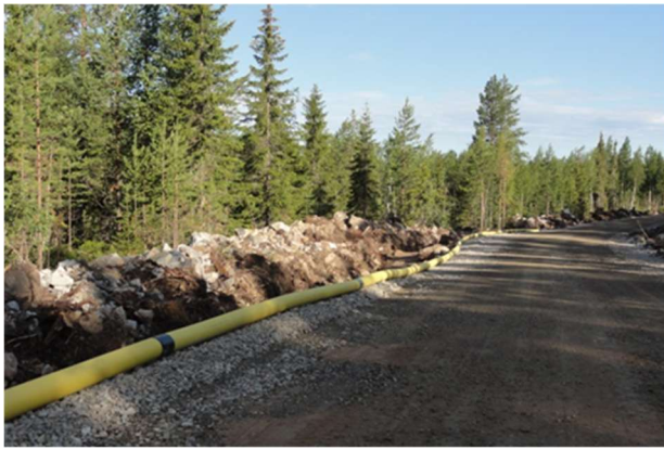
Kuva 73. Vasemmalla kuvassa on esimerkki tuulivoimapuiston rakennus- ja huoltotiestä. Teitä käytetään muun muassa betonin, soran ja voimaloiden komponenttien kuljetuksiin sekä tuulivoimapuiston käyttövaiheessa huoltoajoihin. Maakaapeli sijoitetaan ojakaivantoon tien reuna-alueelle. Oikealla kuvassa tuulivoimalan osia kuljetetaan erikoiskuljetuksina. (Kuvat: FCG).
