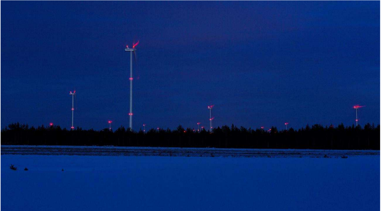
Kuva 69. . Kiinteät punaiset lentoestevalot pimeällä. (Kuva: FCG)
