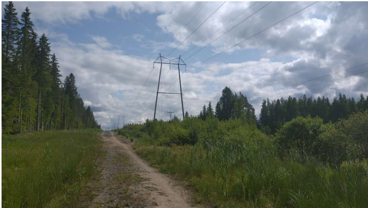
Kuva 9b. Pusikoitunutta sähkölinjan alusta.
