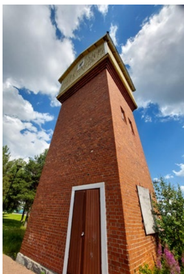
Vanha vesitorni Kasarmin alueella.
