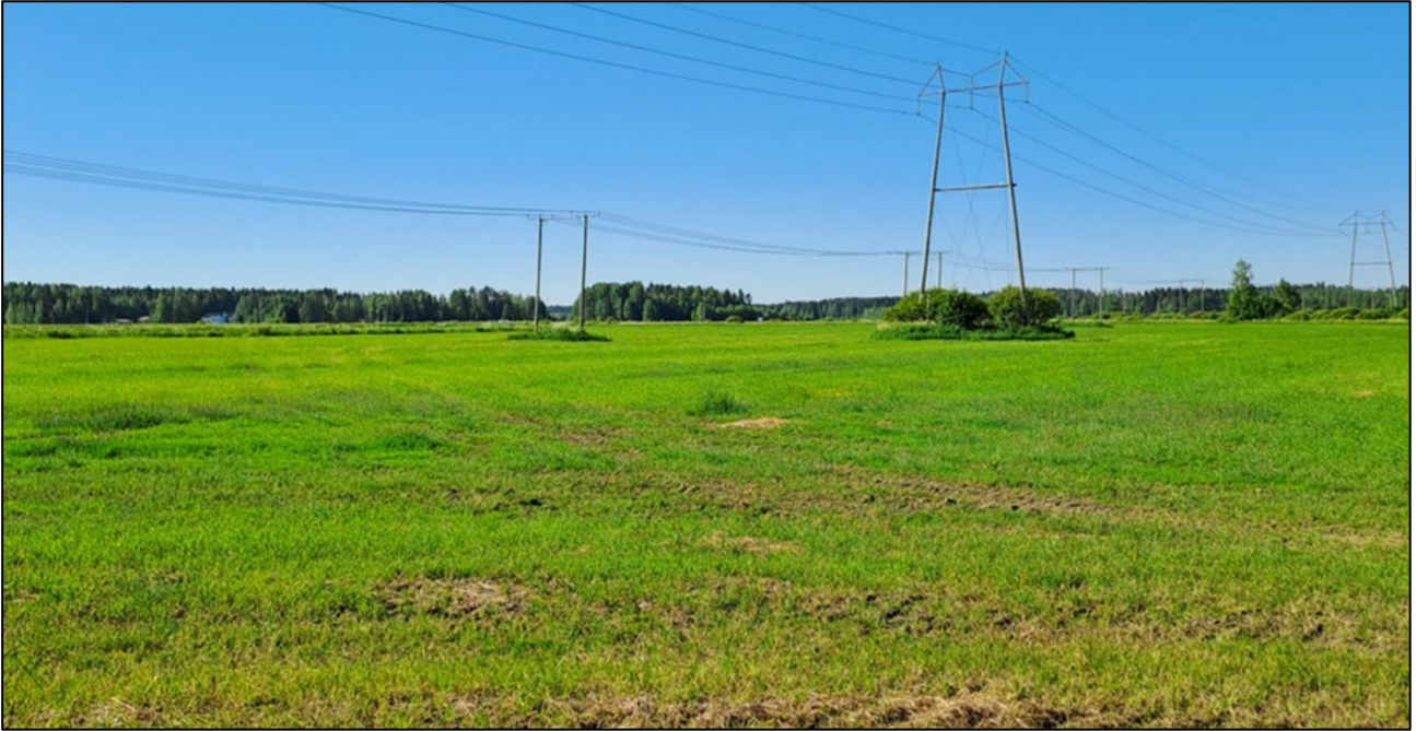
Kuva 4. 110 ja 20 kV:n voimalinjat alueen länsipuolella (Kuva: Ramboll Finland Oy 2024b).
