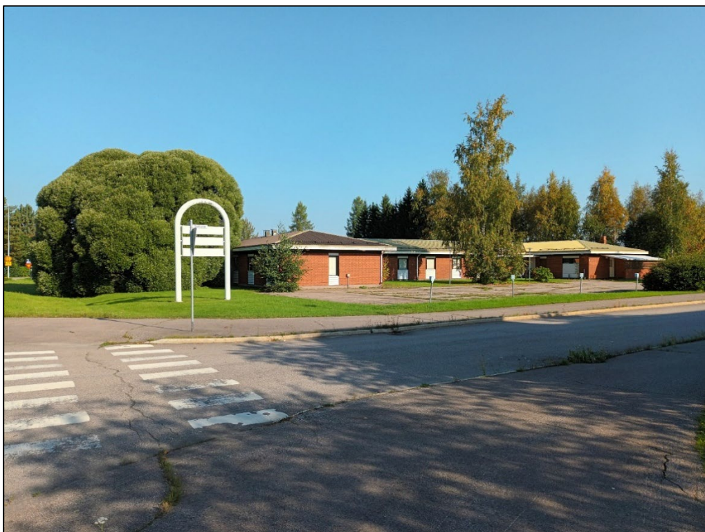
Kuva 4. Suunnittelualueen länsipuolella sijaitsevan korttelin 25 AL 1 -tontin tyhjillään oleva päiväkotirakennus.
